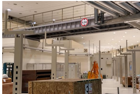
圖十六、輻射屏蔽屋基礎主體、光束線水氣工程線路用支架(左圖)；光束線水氣工程完工現況(右圖)
