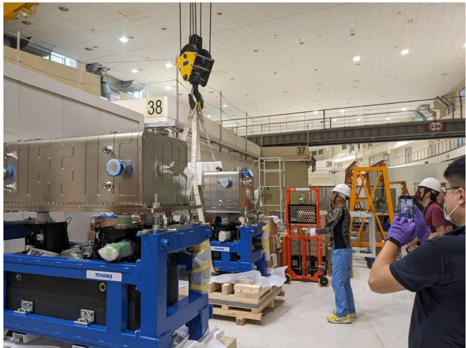
圖十九、準直鏡及超環面聚焦鏡完成安裝測試準備吊掛安裝至光學實驗區
