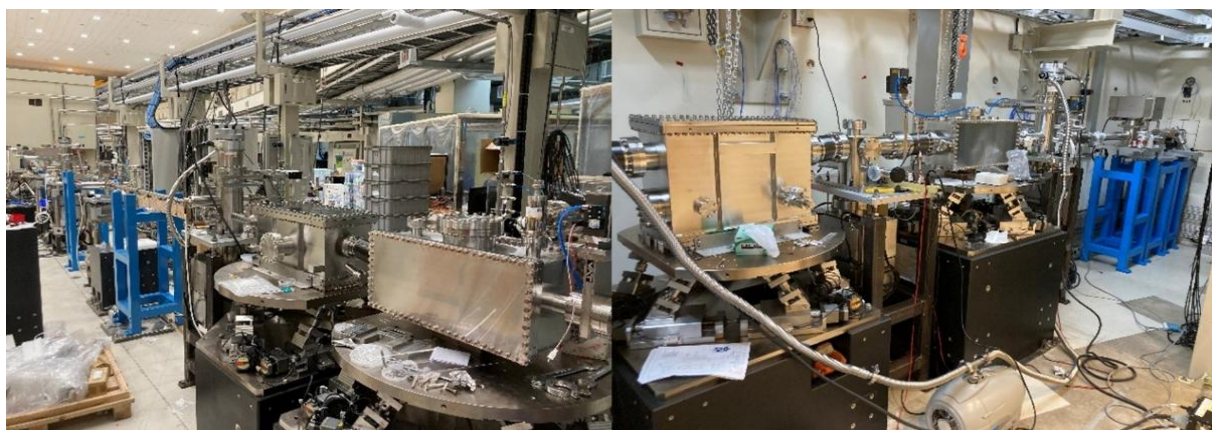
圖二十三、43A 光束線所需重要元件已到貨組裝，完成基本建置工作
