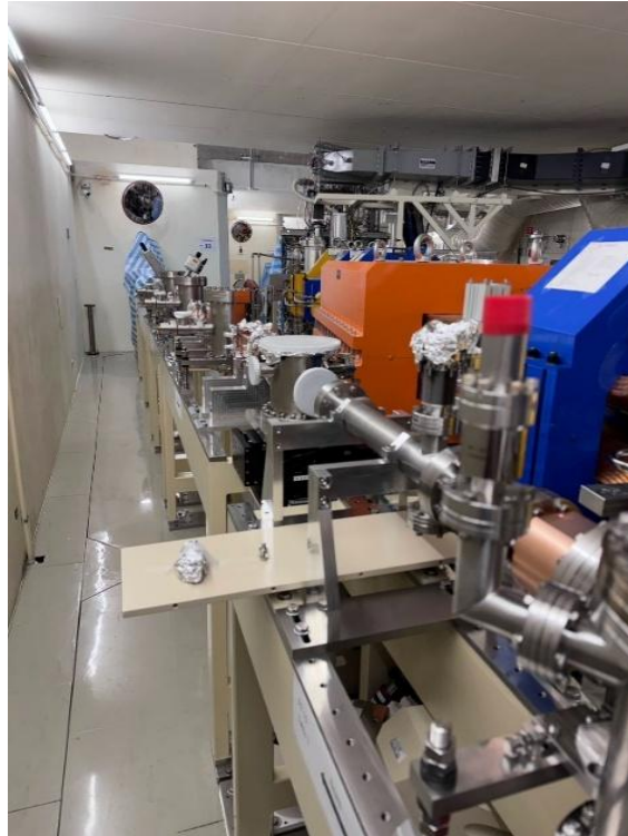
圖十二、真空系統已順利放入 TPS 隧道內
