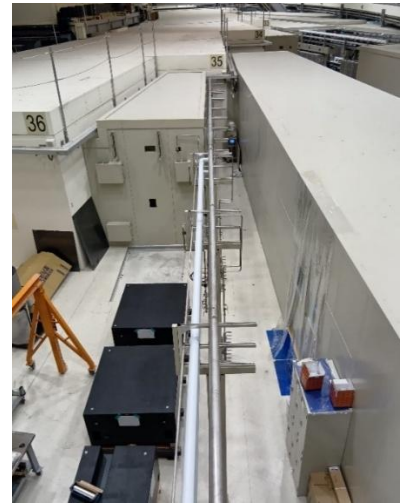
圖十六、輻射屏蔽屋基礎主體、光束線水氣工程線路用支架(左圖)；光束線水氣工程完工現況(右圖)
